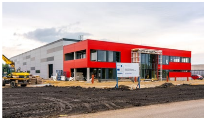
Az épülő szolnoki üzem 2020.11.02.
